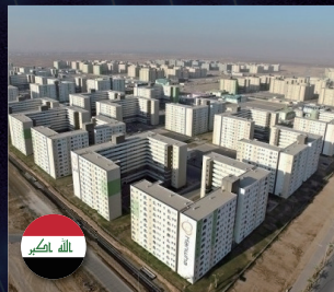
비스마야 신도시 건설 공사 (이라크)
