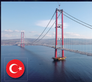
말카라-차나칼레 교량 (튀르키예)
